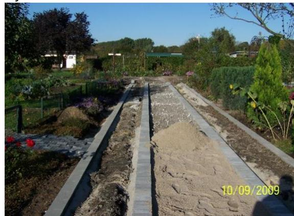
*Setzen der Randsteine und auffüllen der Wege mit Schotter und Sand.*
